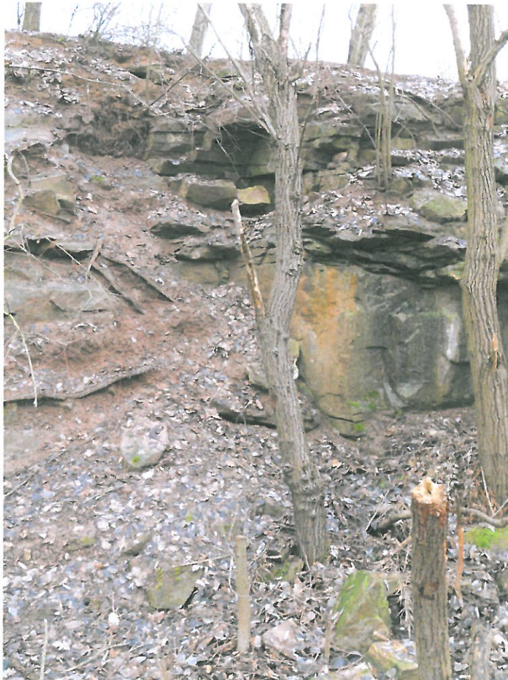
Abbruchkante unterhalb des Baugebietes mit Röttonen und Rötquarzit
