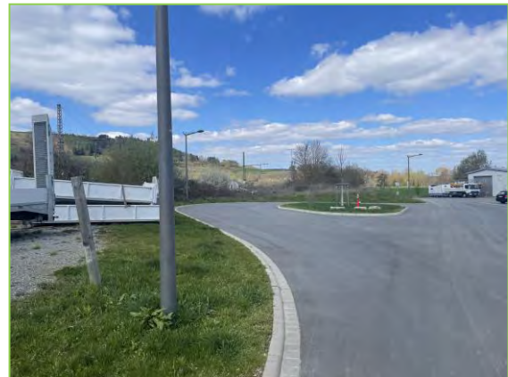
Abb.: Wendeanlage im Norden
