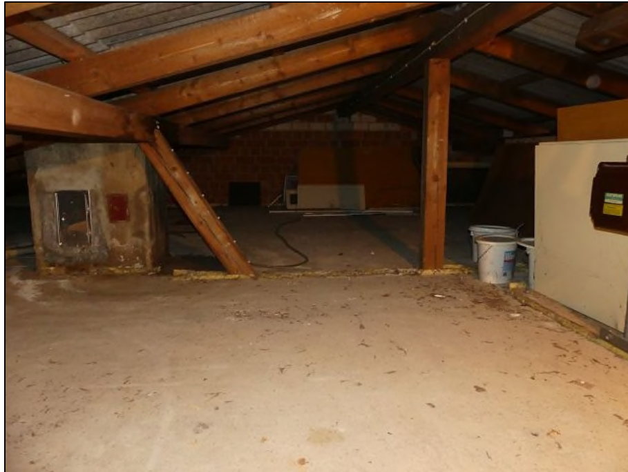
Abb. 7: Dachstuhl des bestehenden Gebäudes, (28.09.2022)
