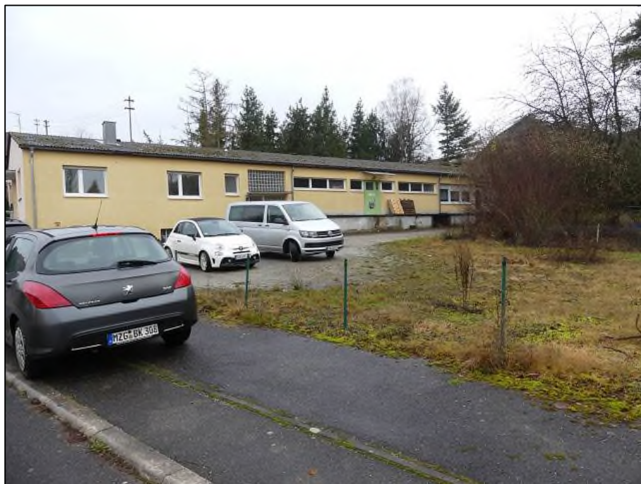
Abb. 4: Bestehendes Gebäude im Süden des Geltungsbereichs, Blick nach Süden (08.12.2021)
