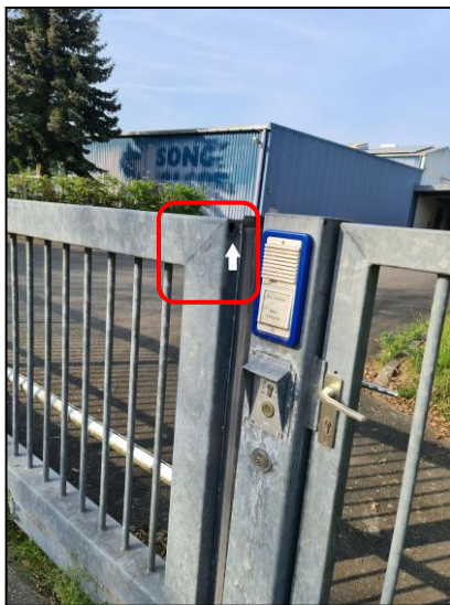
Abb.: Brutplatz einer Blaumeise im Rolltor der Firma Sonoco (Foto: Volkhard Bauer)
