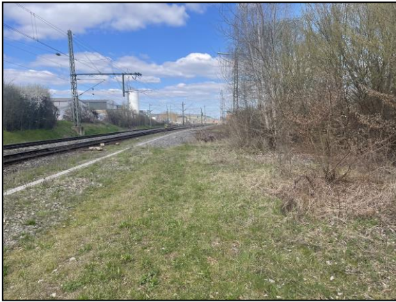
Abb.: Gleisbereich im Süden
